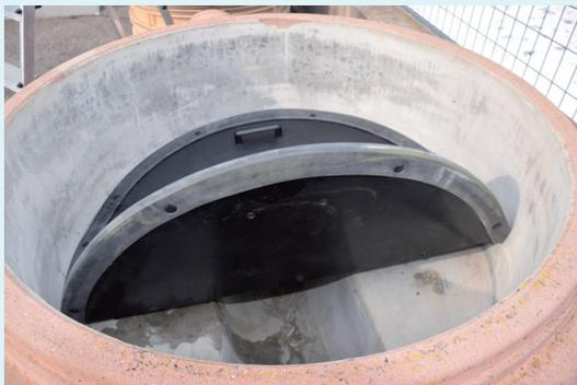
Le couvercle spécialement développé est constitué d'un matériau PE durable, résistant aux acides et aux alcalis. Un système de pliage spécial permet l'insertion et l'assemblage sans connaissances préalables. Le MTA SP 1000 ne nécessite aucun entretien mais peut être facilement retiré du regard et nettoyé si nécessaire à l'aide des poignées de transport prémontées. Le MTA SP 1000 peut être utilisé dans presque toutes les structures de regards de visite municipales et industrielles.
